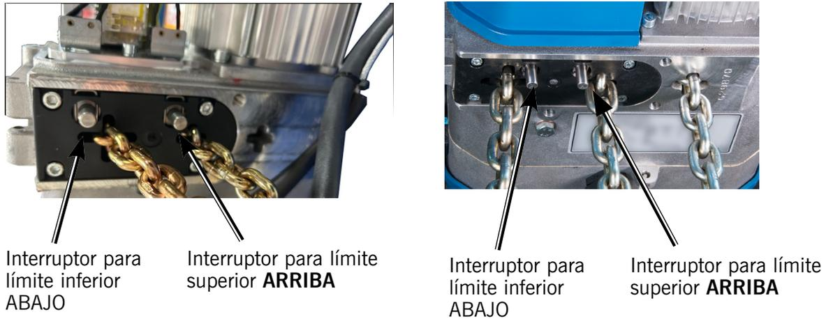
**Diagrama 4-11.** Interruptores de límite de polipastos de caída simple (izquierda) y caída doble (derecha).
